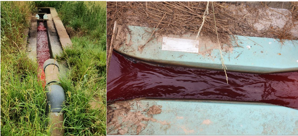
PHOTO 4 : CANAL DE MESURE VENTURI AU NIVEAU DES LAGUNES
