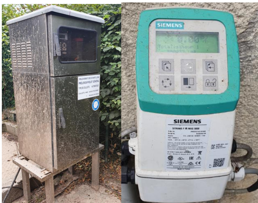
PHOTO 1 : POINT DE PRELEVEMENT ECHANTILLON ET COMPTAGE DU DEBIT DU POINT PR1 AVANT TRANSFERT VERS LES LAGUNES DE BRACHY
